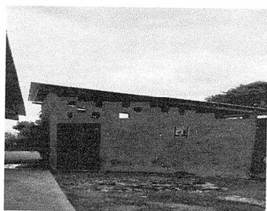
Foto 5: Se observa la cocina remozada totalmente del modulo 2.
