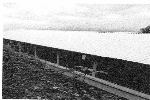
Foto 2: Se observa el completo de la cubierta de láminas portante en el modulo 1.
